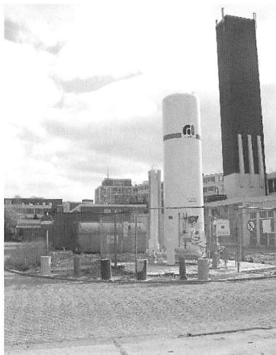
Foto 1 – Voorraadtank van vloeibare zuurstof.
